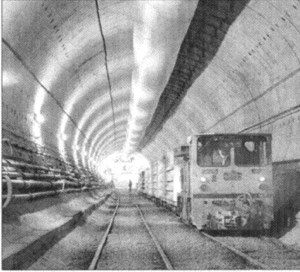
شكل 1-24 أسلاك الألياف البصرية معلقة على جدران نفق قطار (تقدمة QA photos Ltd)
